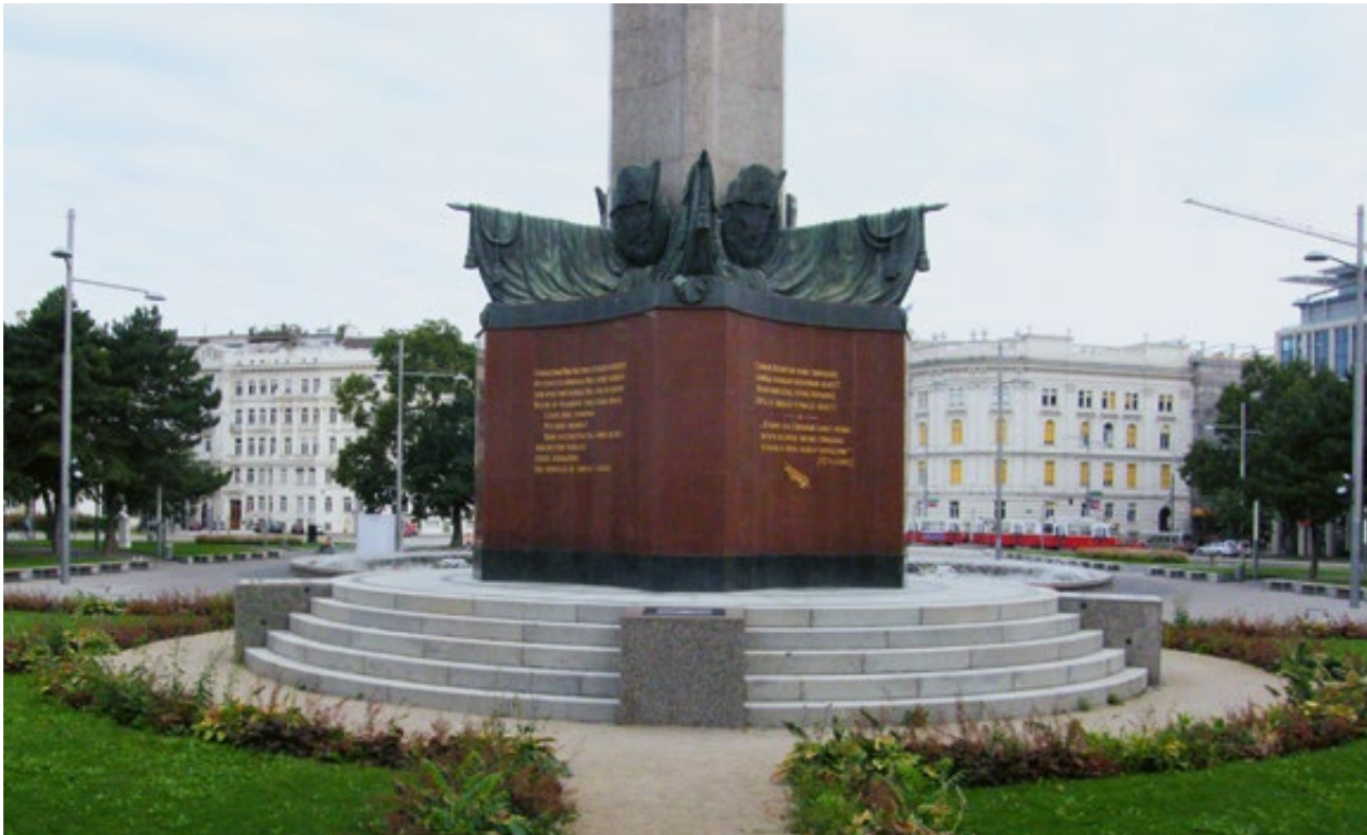
Abb. 13 Blick auf Stufen, Sockel und Pfeiler, welche die Soldatenfigur tragen
